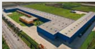
Hörmann Tianjin, Kína
